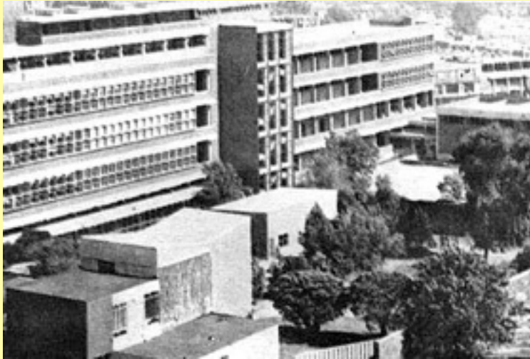
Pabellón Van de Graaf 1953 en Ciudad Universitaria
